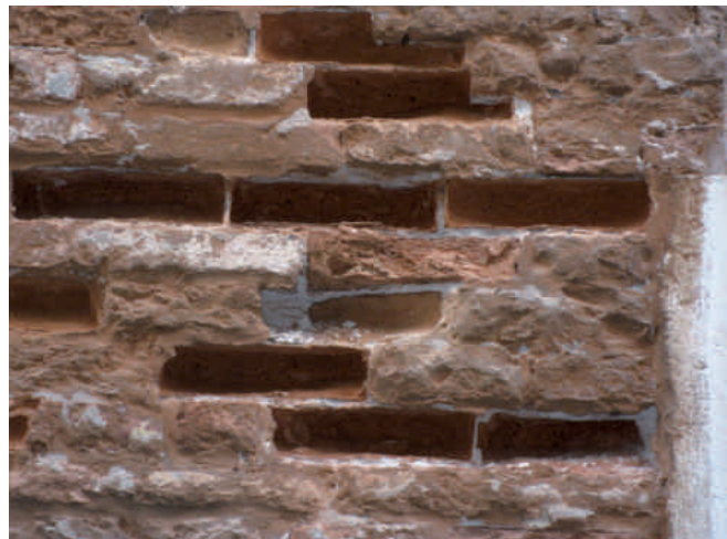
Abb. 2. Flächige Salzausblühungen auf Ziegeloberfläche und Gefügauflösung einzelner Ziegel.
